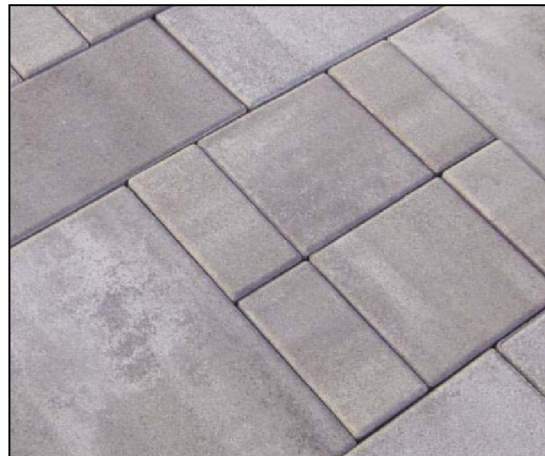
Figura 2 - Pavimentazione in lastre di cls della stessa tipologia e differente dimensione
